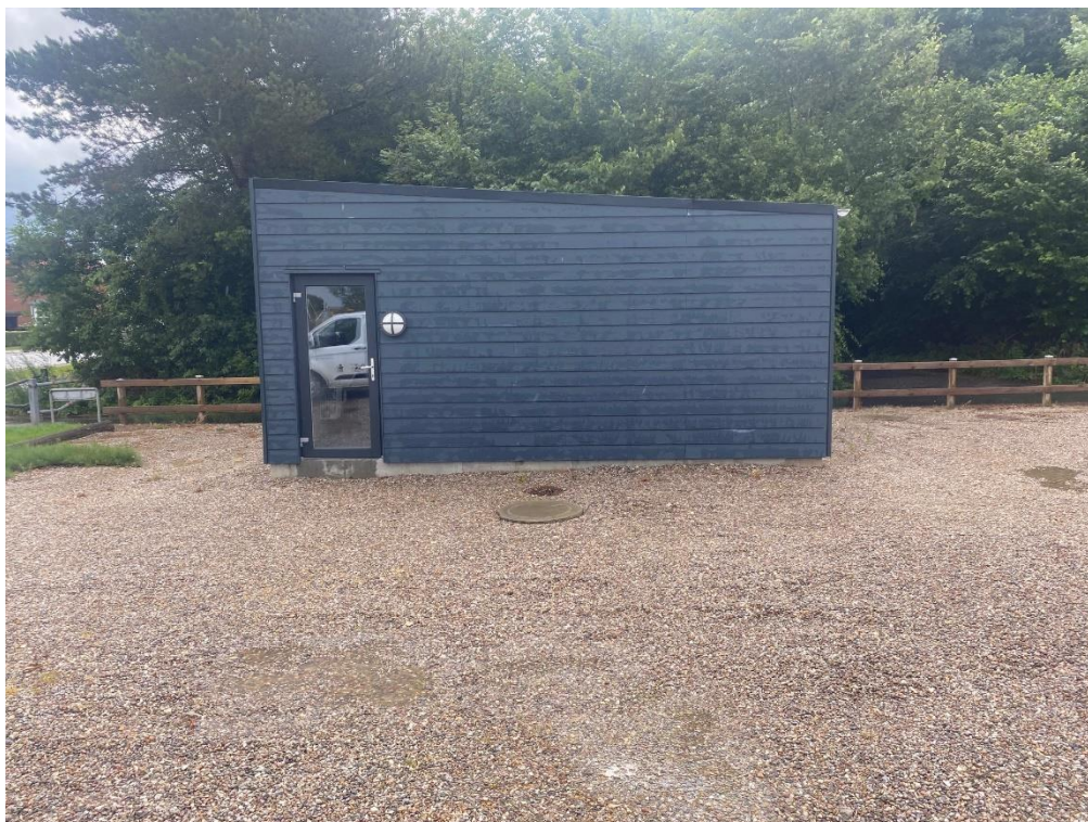
Billede 4 - Pumpehus set fra Vest
